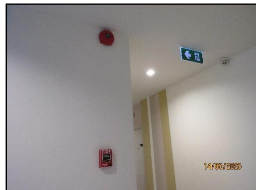
รูปที่ 29 เครื่องส่งสัญญาณไฟแบบกริ่ง (Alarm Bell) และอุปกรณ์แจ้งเหตุ (Switch Board)
