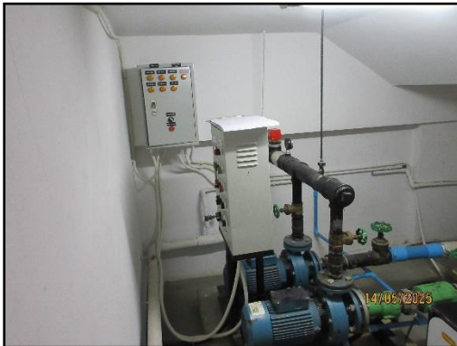
รูปที่ 19 ปั๊มถังเก็บน้ำชั้นใต้ดิน
