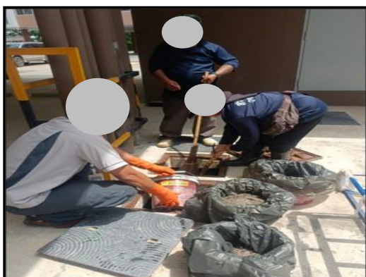
รูปที่ 47 ตักไขมันและตะกอนนอกระบบบำบัด
