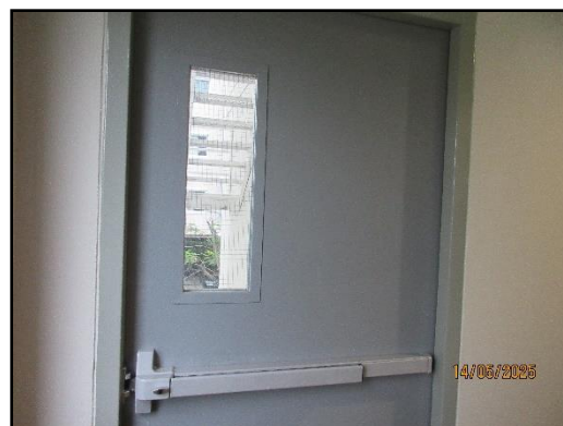
รูปที่ 45 ประตูหนีไฟภายในโครงการ
