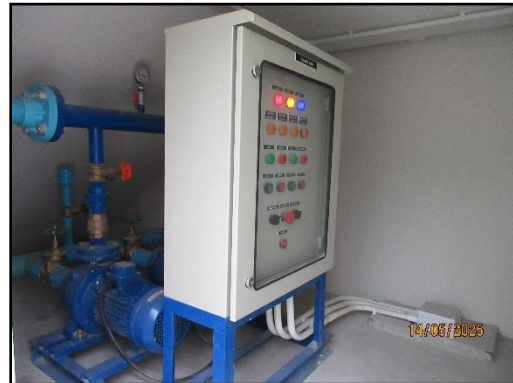
รูปที่ 19 ปั๊มถังเก็บน้ำชั้นใต้ดิน
