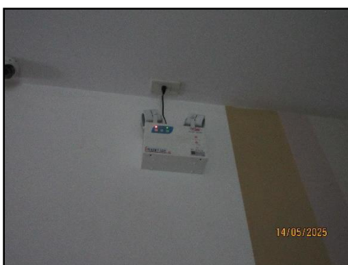
รูปที่ 35 ไฟส่องสว่างฉุกเฉิน
