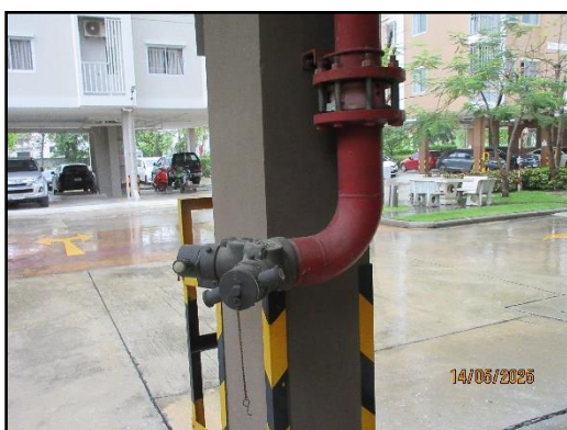
รูปที่ 46 หัวรับน้ำดับเพลิงภายในโครงการ
